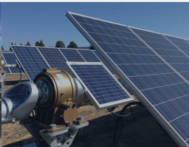
ESTRUCTURA CON SEGUIDOR (TRACKER)
