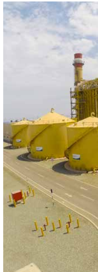
CENTRAL FENIX POWER PERÚ
