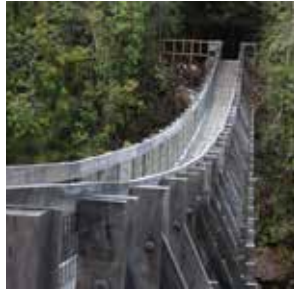
Puente Colgante en Central Canutillar
