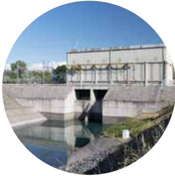
CENTRAL HIDROELÉCTRICA SAN IGNACIO (CENTRAL DE PASADA)
