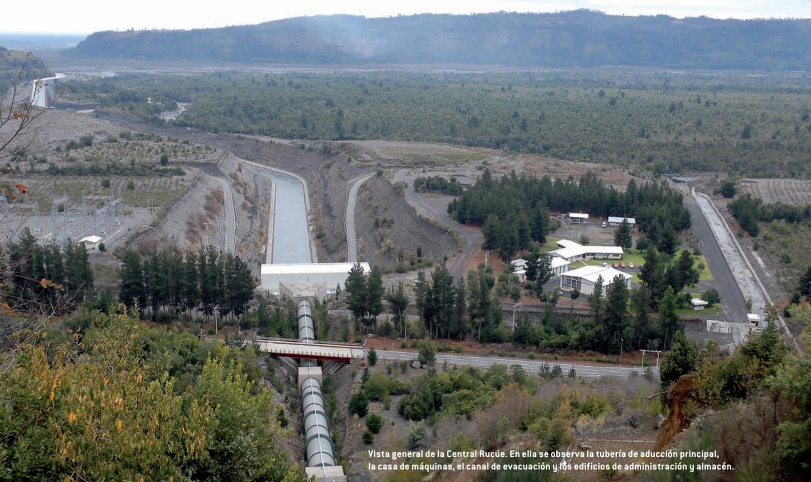
Vista general de la Central Rucúe. En ella se observa la tubería de aducción principal, la casa de máquinas, el canal de evacuación y los edificios de administración y almacén.
