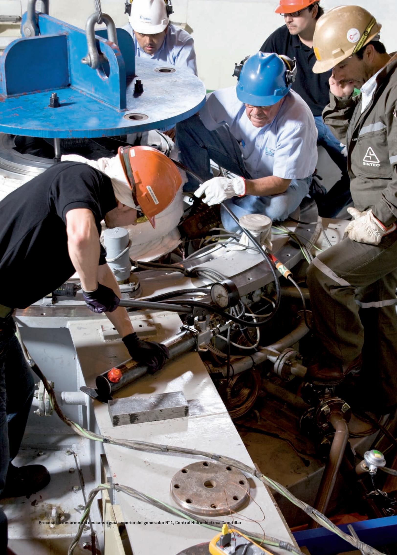
Proceso de desarme al descanso guía superior del generador N° 1, Central Hidroeléctrica Canutilar
